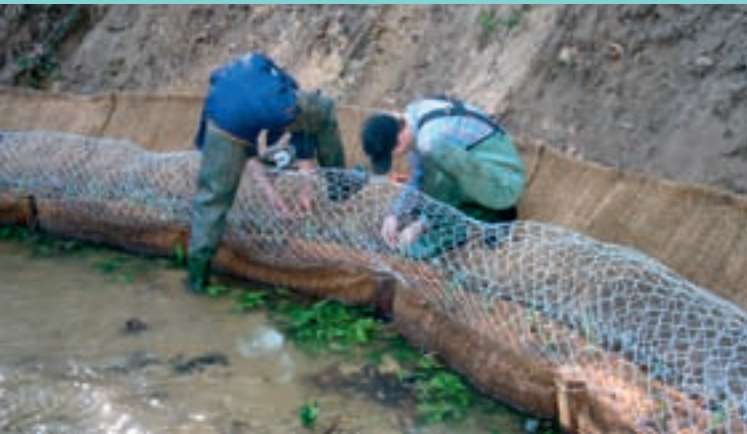
Pose d'une protection anti-rongeurs
