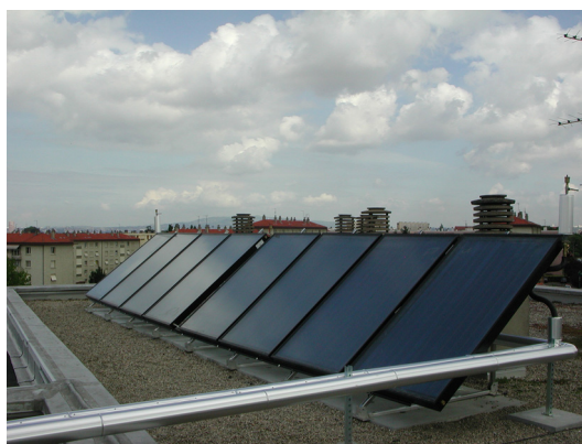
Photo 1 : Installation solaire thermique collective de préchauffage de l'eau chaude sanitaire (surface : 35 m 2 ) - Bron
