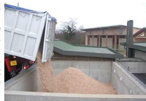
Photo 2 : Stockage de la chaufferie de la Tour-de-Salvagny (69)
